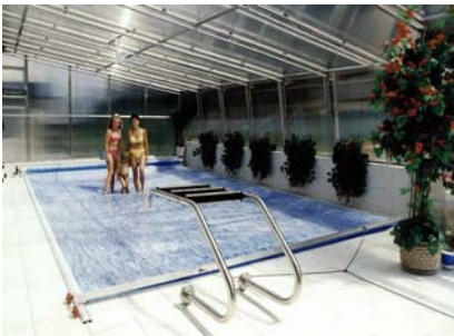
1. Godkjent person sikring Tåler noe snøbelastning
