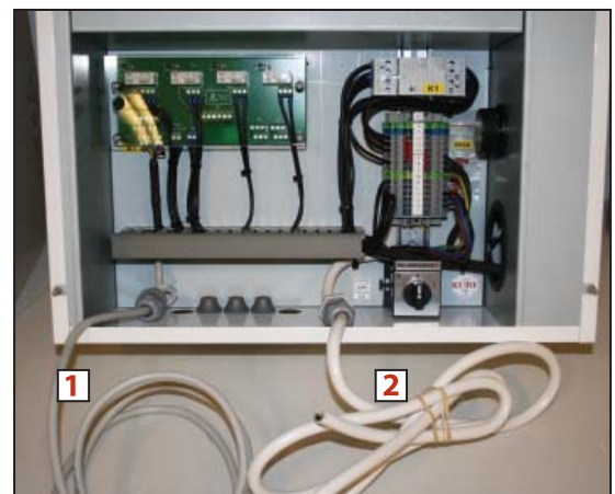
1: Kabel til relestyring 2: Kabel til varmtvannsbereder
