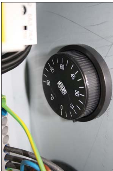
Termostat, manuell drift, settes i 0 når VP er i drift. Brukes kun til nøddrift av el-elementet når VP er ute av drift.
