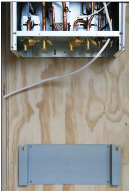
Merk høyde fra innedel. Merk så senter på innedel og monter festeplaten midt på senterlinjen. Så kan Modul 1 henges opp.
