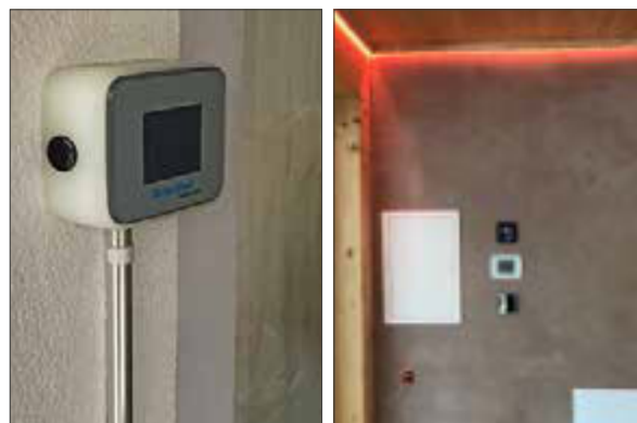
Touchdisplay an der Wand montiert
