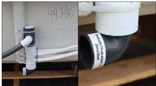
Ansaugf fitting: Anschluss d50 = Saugseite Jetpumpe 1,0 kW
