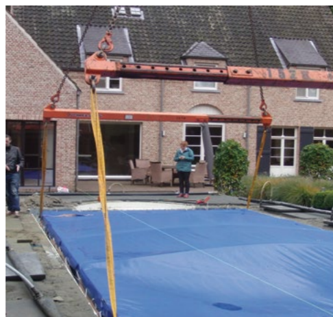
Die Konstruktion wird im Werk und nicht auf der Baustelle gefertigt. Unser Spezialtransporter bringt Ihren Pool hochkant bzw. im Breittransport gelagert an die Baustelle. Auch mehrteilige Becken sind möglich - Fügstellen werden dann vor Ort mit Mosaik überarbeitet.
