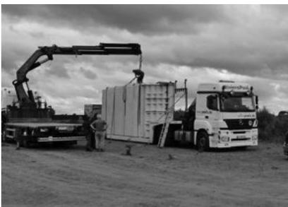
Abb. links: Abladen des Beckens per Autokran..
