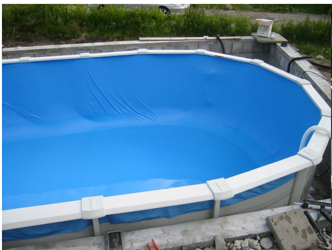
5. Start fylling av vann under vakuüm.
