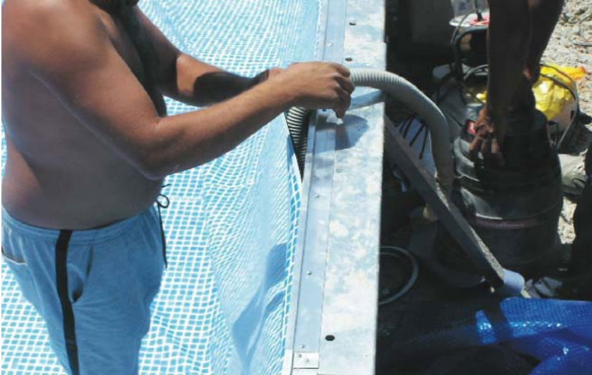
Montering av støvsuger for vakuumsug. Her vist mellom vegg og liner på en langvegg.
