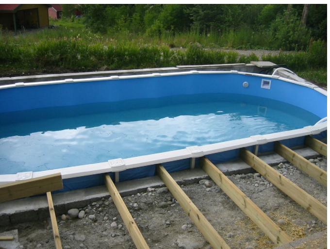
6. Basseng halvfyllt med vann hvor alt er ferdig strukket.
