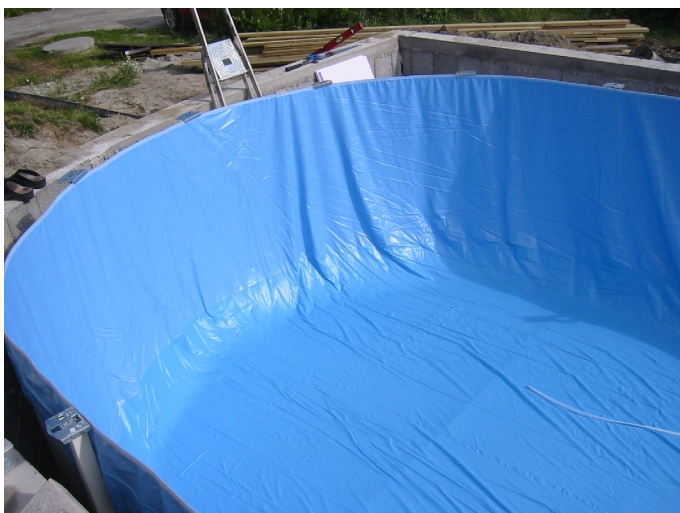
3. Bassengpose ferdig montert før vakuüm
