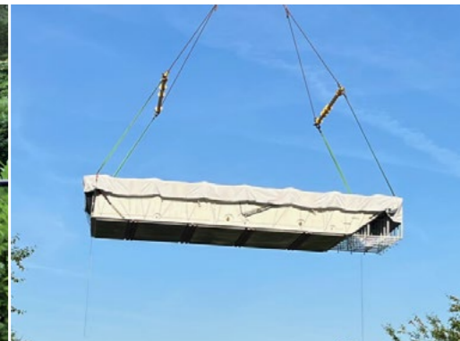
Einbringung des MLine Beckens per Kran.
