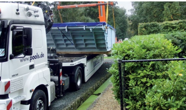
Saubere Sache: Das Mosaikbecken kommt fertig gefliest aus dem Werk bei Ihnen an.
